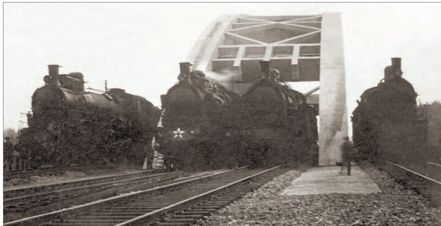
Рис. 3. Испытания Химкинского железнодорожного моста через канал им. Москвы четырьмя составами одновременно (1935 год)
