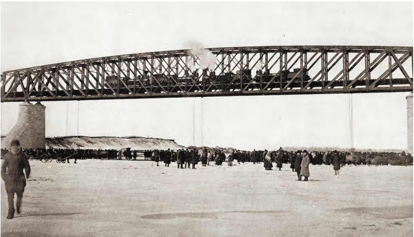
Рис. 1. Испытания моста через реку Обь в Ново-Николаевске (ныне — Новосибирск), (1897 год). Приемочная комиссия и строители находятся под мостом.
