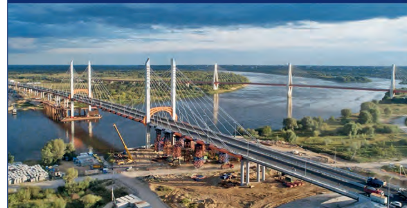
Объекты скоростной автомобильной трассы М-12. Мост через р. Оку. Металлические конструкции: ИЗОЛЭП-primer + ИЗОЛЭП-mio + ПОЛИТОН-УР(УФ) и другие Железобетонные конструкции: АЛИСТЕРУС 3105, ФЕРРОТАН + ФЕРРОТАН-про + ПОЛИТОН-УР(УФ)
