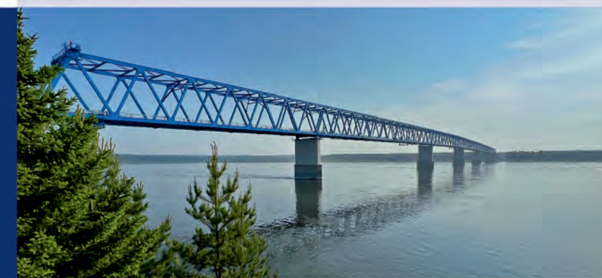
Высокогорский мост через р. Енисей. Красноярский край Металлические конструкции: ЦИНОТАН + ПОЛИТОН-УР + ПОЛИТОН-УР(УФ)
