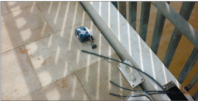
Фото 3. Расположение датчиков на пролетном строении
