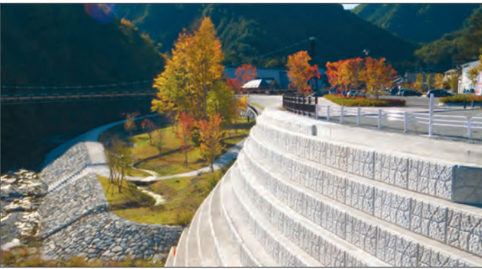
Рис. 5. Берегоукрепительное сооружение из блоков КБП
