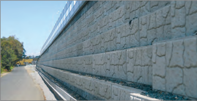
Рис. 3. Низовая подпорная стена автодороги из блоков КБП
