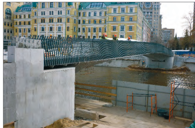
Фото 1. Общий вид моста через водоотводной канал Москвы-реки
