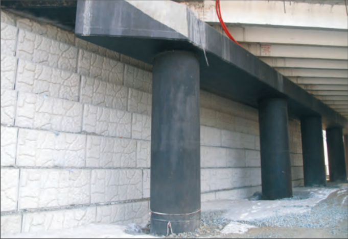
Рис. 2. Устой автодорожного моста в виде подпорной стены из блоков КБП
