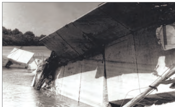
Обрушение моста через реку Белую на М-5, 1983 год
