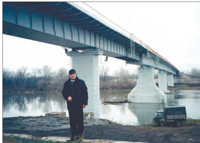
Мост через р. Белую в Уфе
