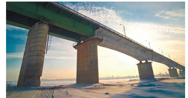
Металлическое пролетное строение моста через реку Сухону в Великом Устюге, 1986 год
