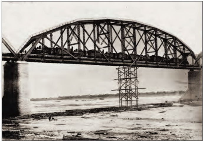
Рис. 2. Испытания моста через реку Зею в Алексеевске (1914 год). В серединах пролетов установлены вспомогательные конструкции для измерения прогибов пролетного строения от испытательной нагрузки; а — в пролете 1 установлено 2 паровоза; б — в пролете 4 установлено 6 паровозов
