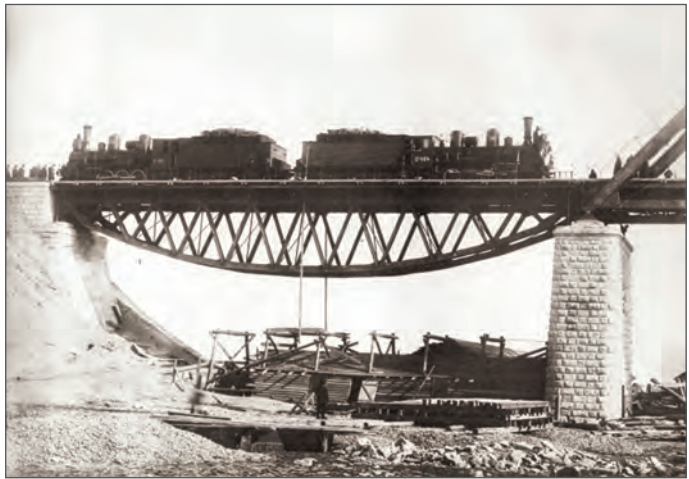
Рис. 2. Испытания моста через реку Зею в Алексеевске (1914 год). В серединах пролетов установлены вспомогательные конструкции для измерения прогибов пролетного строения от испытательной нагрузки; а — в пролете 1 установлено 2 паровоза; б — в пролете 4 установлено 6 паровозов
