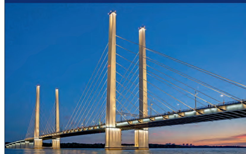
Мостовой переход «Архангельский» через р. Шексну, г. Череповец Металлические конструкции: ЦИНОТАН + ПОЛИТОН-УР + ПОЛИТОН-УР (УФ) Железобетонные опоры и пилоны: ФЕРРОТАН-про + ФЕРРОТАН + ПОЛИТОН-УР (УФ)
